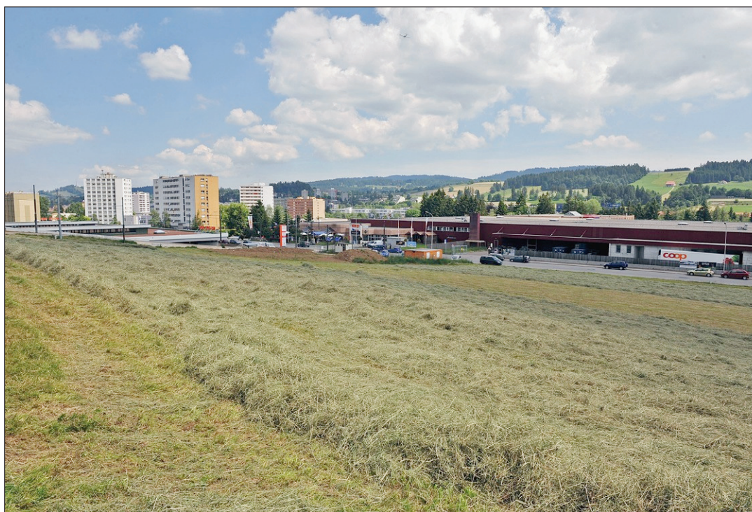
EPLATURES Son centre MM inauguré, Migros vend la parcelle voisine dont elle n'a plus besoin. Par ailleurs, elle se propose d'aménager elle-même la portion de la rue Charles-Naine devant le centre. (CHRISTIAN GALLEY)
