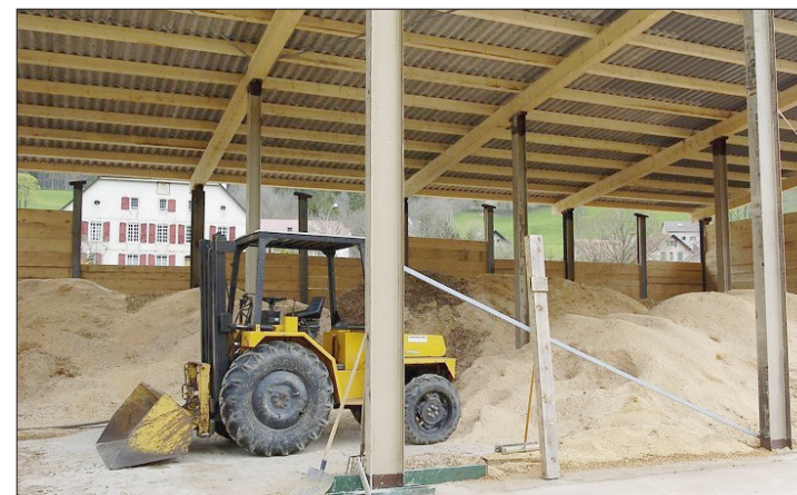
PELLETS Le séchoir de l'usine à pellets, qui n'était pas muni d'un thermostat, a surchauffé et provoqué un incendie.
