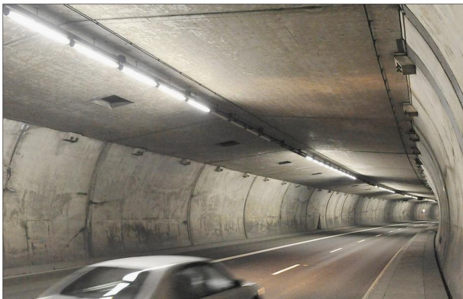
**TUNNEL.** En hiver, plaques de glace et glaçons y sont légion. Lors de sa construction, il a en effet été décidé d'économiser en supprimant l'étanchéité dans sa partie centrale.
