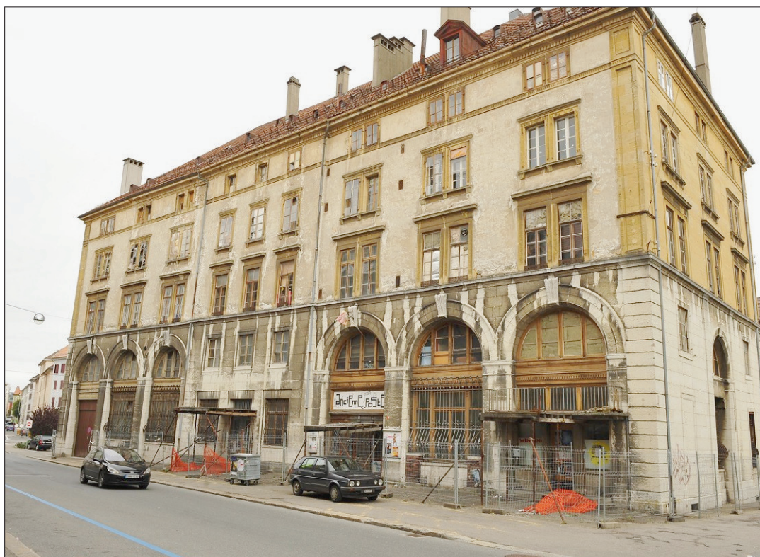
DÈS LE PRINTEMPS! La reprise en sous-œuvre commence d'ici un mois à six semaines. Des travaux peut-être pas très spectaculaires, mais complexes. (ARCHIVES RICHARD LEUENBERGER)
