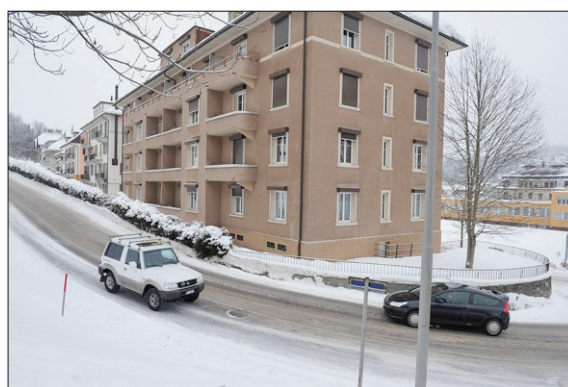
RÉFECTION Rues des Fiottets et de Jean-d'Arberg seront en travaux à la belle saison.
