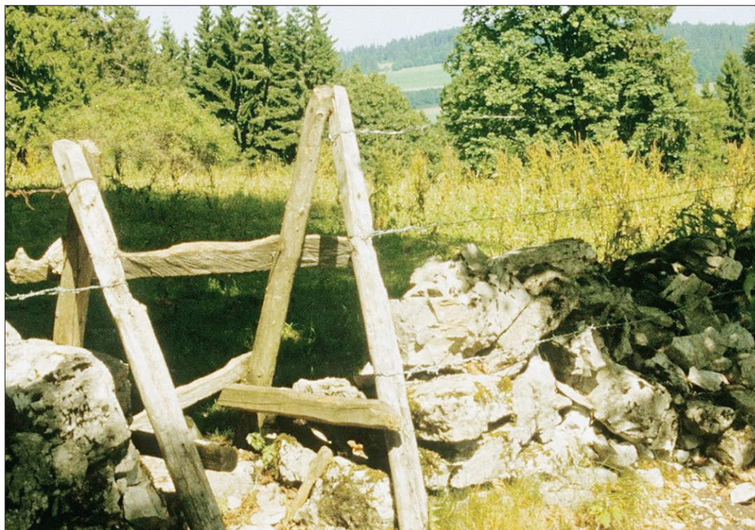
ILLUSTRATIONS Comme ici aux Breuleux, les murs en pierres sèches se font carrément démonter en certains endroits, pour la création de passages. (MARCEL JACQUAT)
