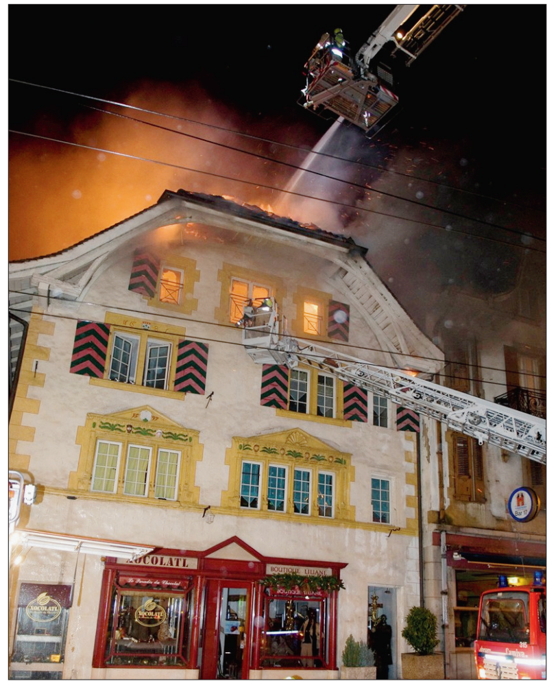
EMBRASEMENT Les combles et la toiture de cet immeuble historique de la Grand-Rue de Peseux ont été entièrement ravagés par le feu. (DAVID MARCHON)
