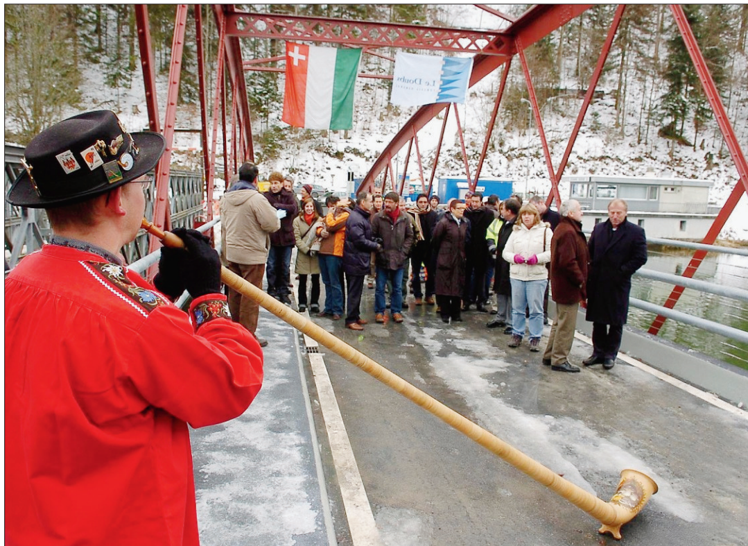
BIAUFOND Sur un air de cor des Alpes, la réouverture du pont franco-suisse hier en fin de matinée a été saluée par les autorités des deux rives du Doubs. A noter qu'il n'est plus qu'à une piste. (RICHARD LEUENBERGER)
