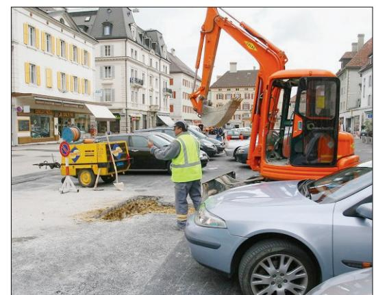
**PLACE DU MARCHÉ** On perce encore à plusieurs endroits. Ici pour poser le socle d'un candélabre, plus loin pour des armoires électriques.
