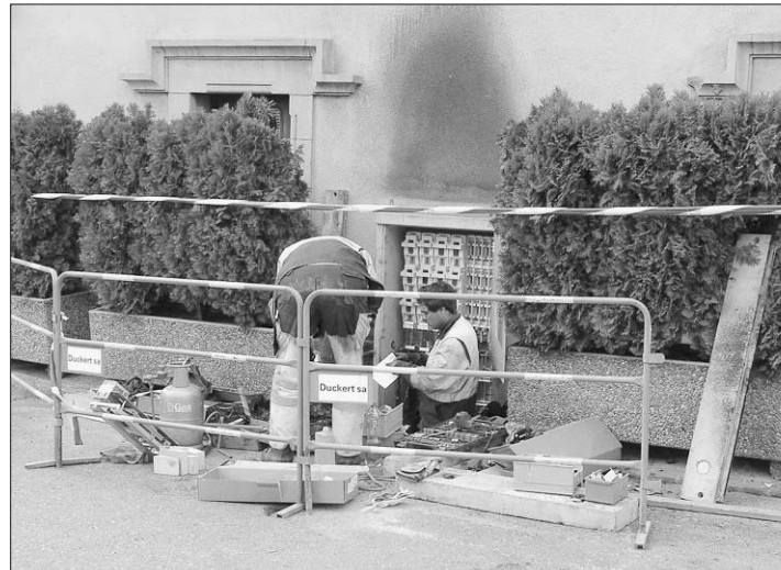
DÉGÂTS La façade de l'hôtel de la Couronne de Colombier a été noircie par l'incendie de la station électrique. (RICHARD LEUENBERGER)
