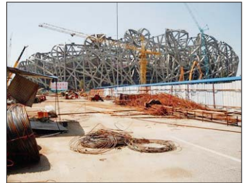
STRUCTURE COMPLEXE Le stade olympique sera le seul site non terminé à la fin de l'année 2007. (KEYSTONE)
