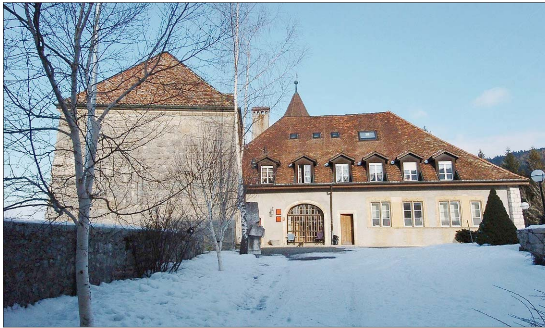
CHÂTEAU DE MÔTIERS Les travaux pourront commencer dès la vente signée. (ARCHIVES RICHARD LEUENBERGER)
