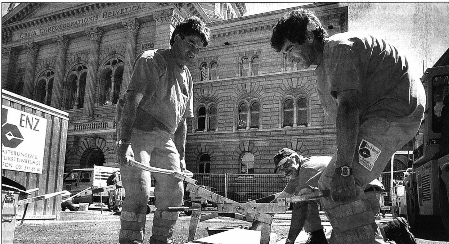
Au lendemain d'une nouvelle défaite pour le gouvernement et le parlement, les socialistes veulent constituer une majorité avec «la droite raisonnable». En attendant, les travaux vont bon train sur la place fédérale. PHOTO KEYSTONE
