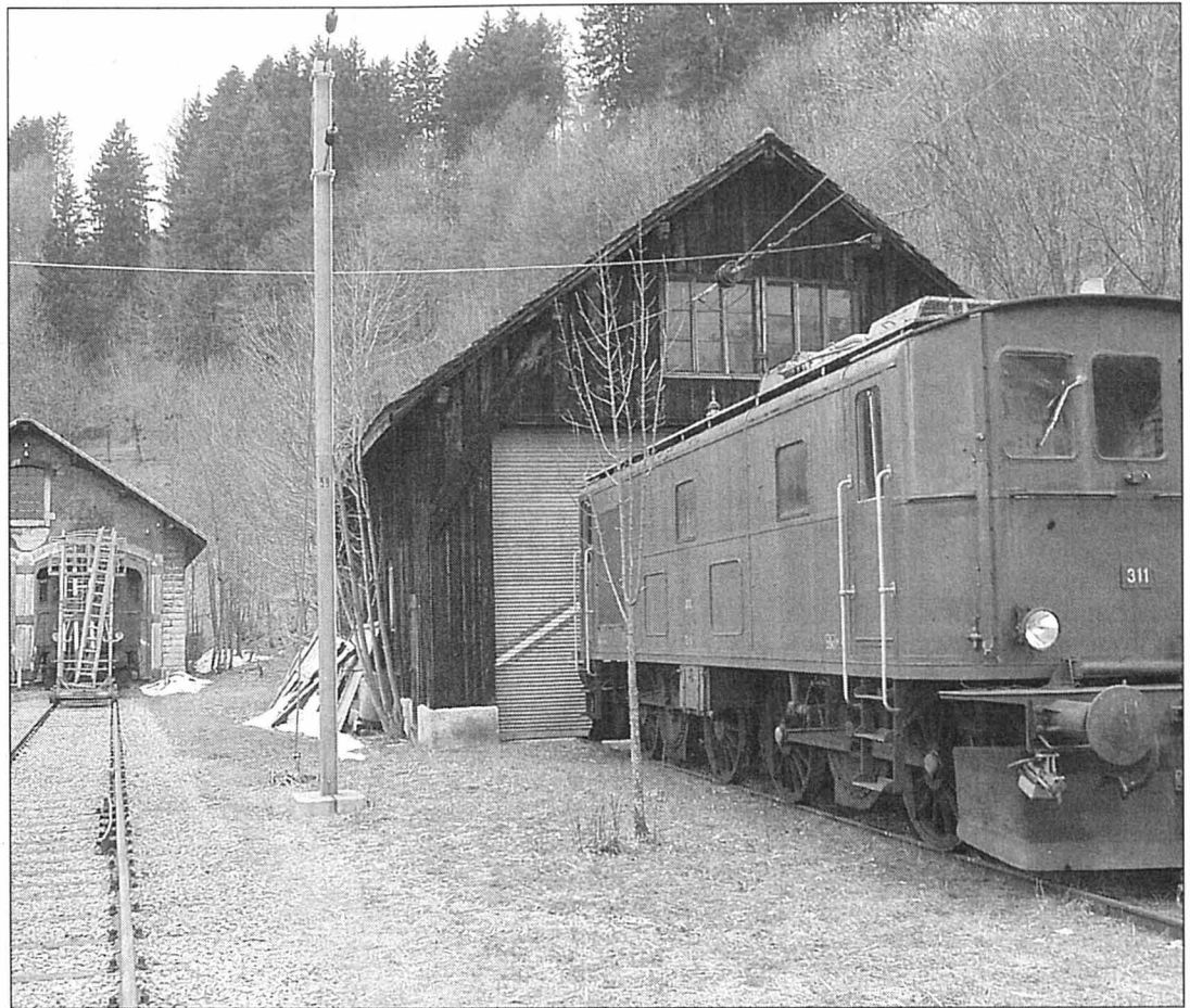
Les deux dépôts ont été construits en 1915 et sont dotés de cheminées pour l'évacuation de la fumée des locomotives à vapeur.
