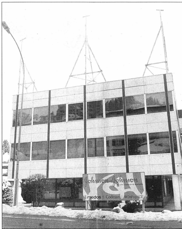
Sur la route cantonale, les deux étages supplémentaires de l'administration sont piqués de gabarits. PHOTOS LEUENBERGER
