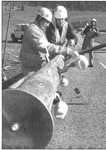
On équipe le nouveau poteau.
