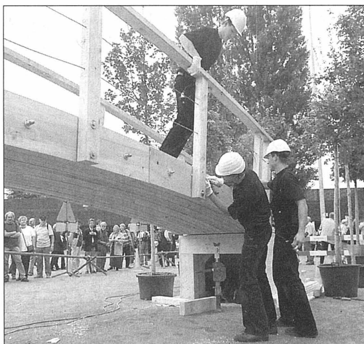
Des apprentis de Schaffhouse construisent un pont sur l'artéplage de Neuchâtel.
