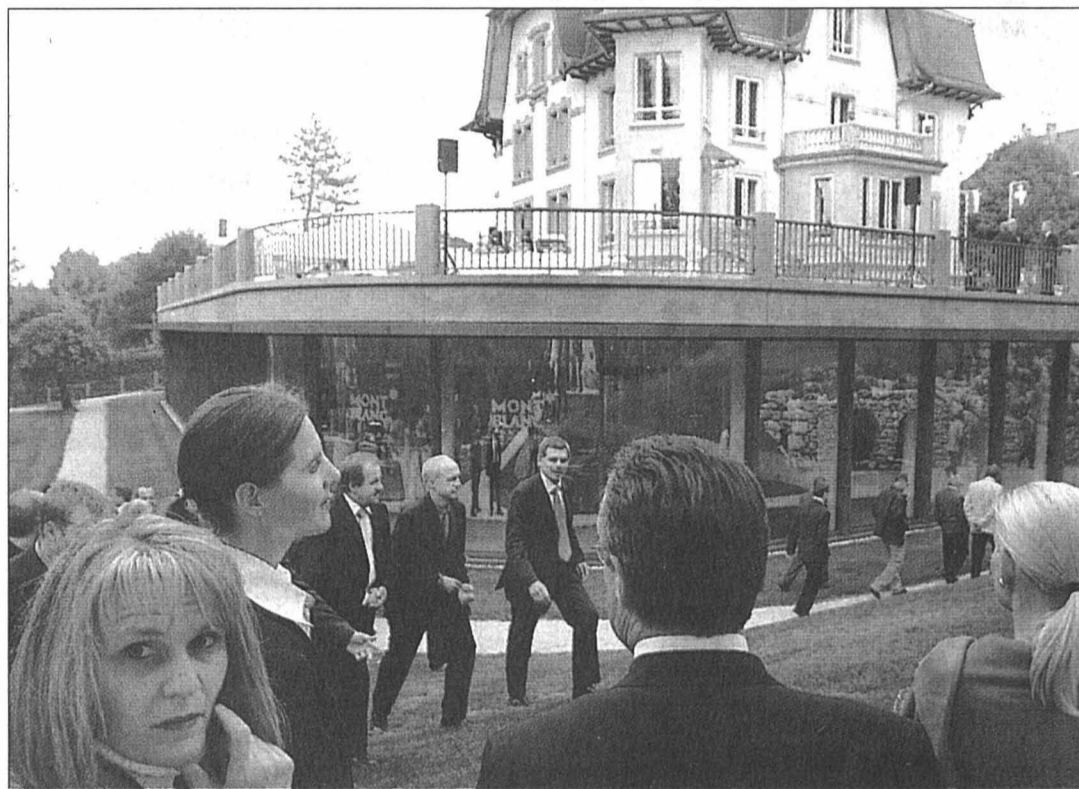
A la rue des Tourelles, l'extension de Montblanc Montre a été inaugurée l'automne dernier au Locle. PHOTO ARCH-GALLEY
