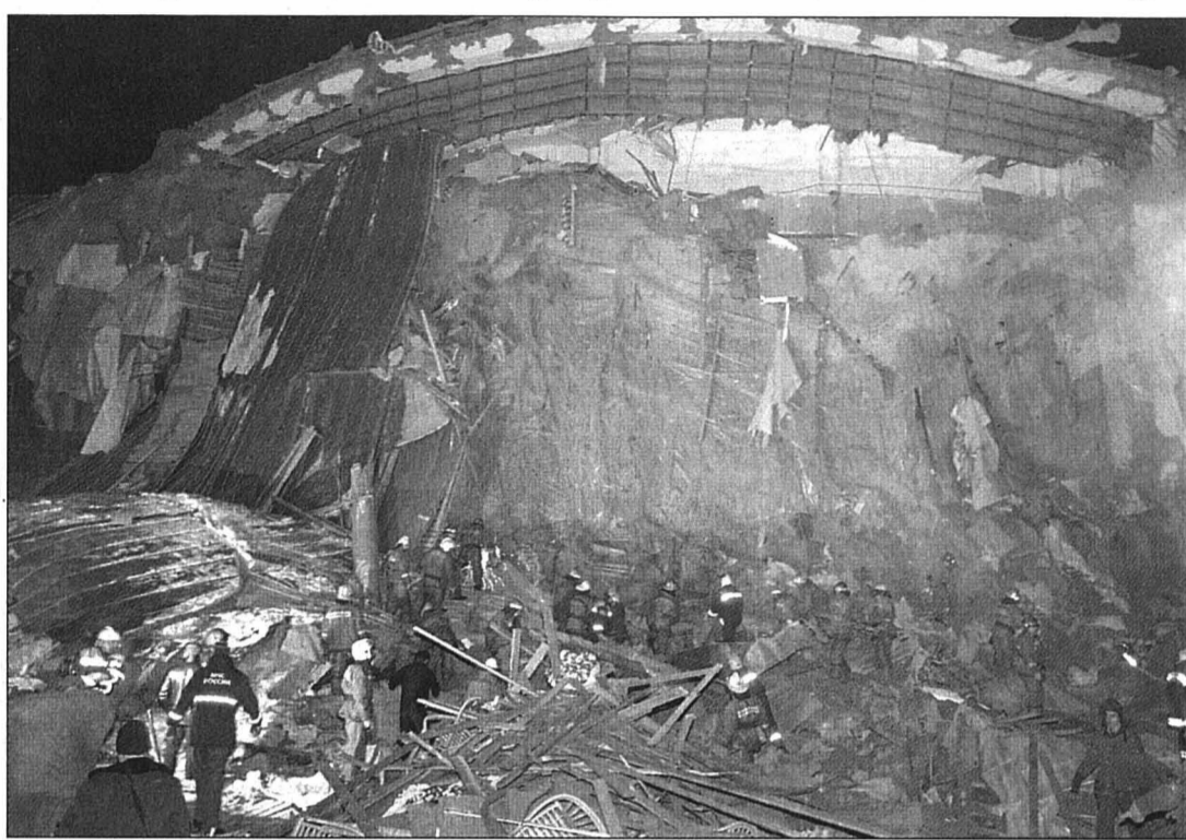
Des secouristes recherchent d'éventuels survivants au milieu des débris de la coupole du centre aquatique «Transvaal Park», à Moscou. PHOTO KEYSTONE
