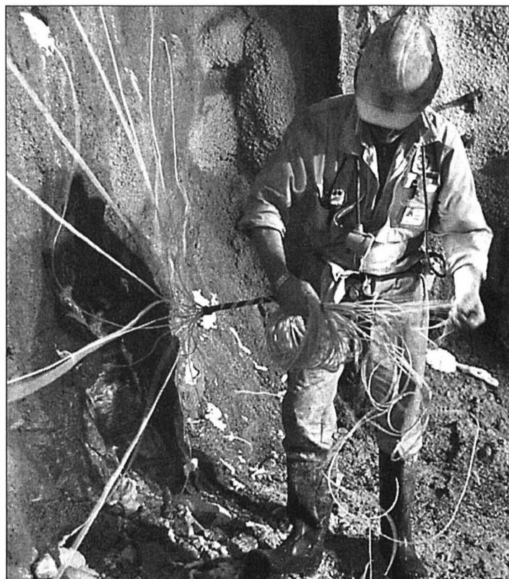
Au Gothard, les travaux se poursuivent.
