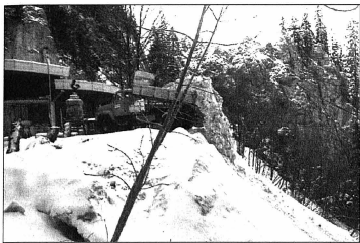
A quelques minutes du Locle, la combe de la Rançonnière est précieuse pour déverser la neige. PHOTO PERRIN
