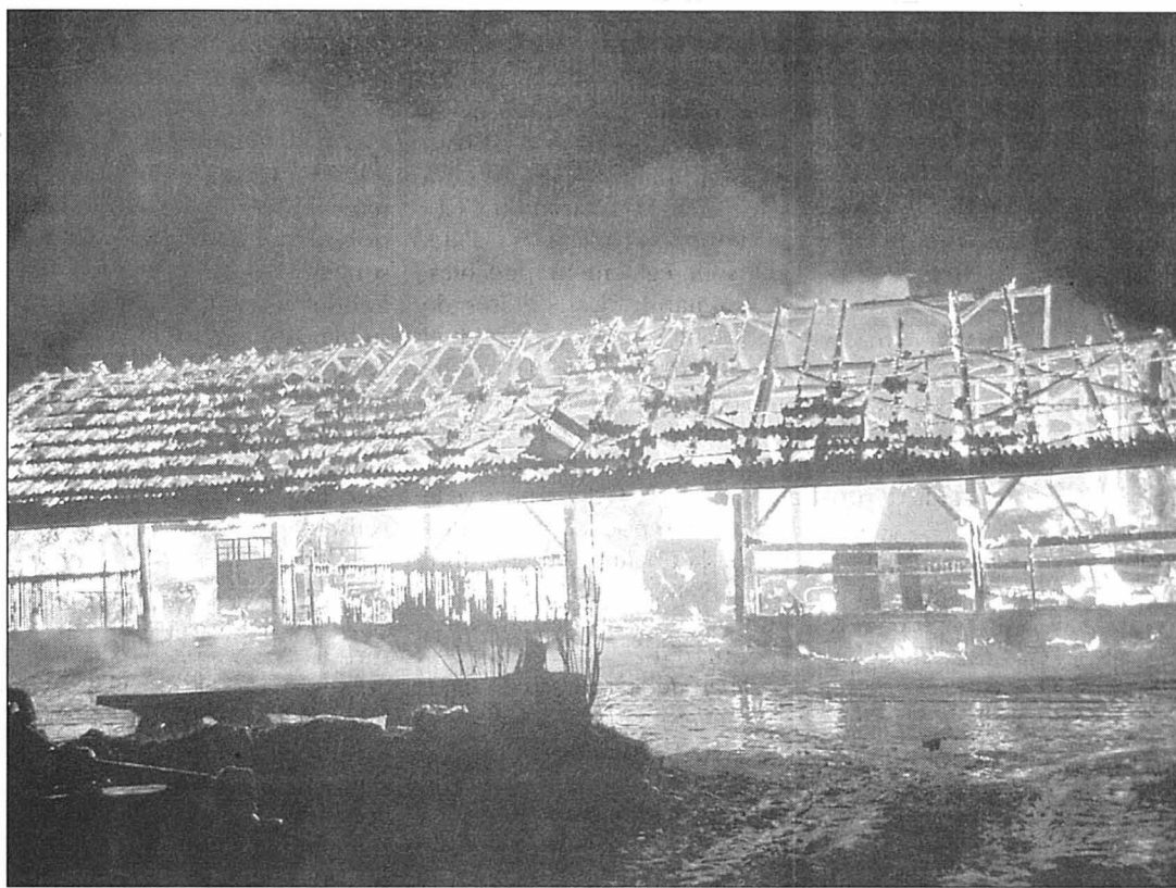
Arrivés les premiers sur les lieux, les pompiers verriens n'ont pu que constater l'ampleur des dégâts.
