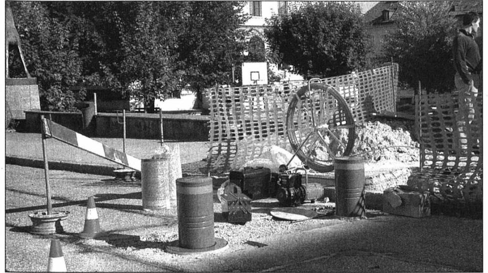
Deux bornes fixes encadrent une borne escamotable au centre de la rue du Progrès. Seuls les détenteurs d'une clé pourront franchir ce barrage.
