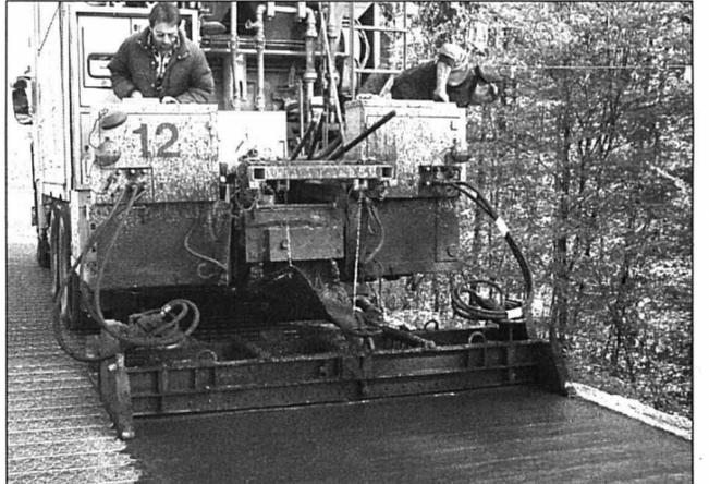
Jeudi, avant la pose de la couche finale de bitume, les ouvriers coulaient un enrobé pour maintenir une grille métallique de renforcement posée sur toute la chaussée. PHOTO DE CRISTOFANO
