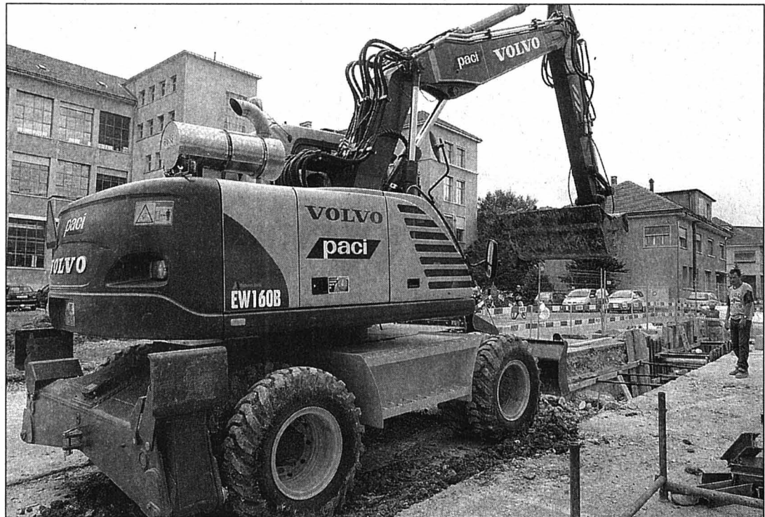
Sur ce chantier, le creusage est effectué par une nouvelle pelle mécanique dotée d'un filtre à particules.
