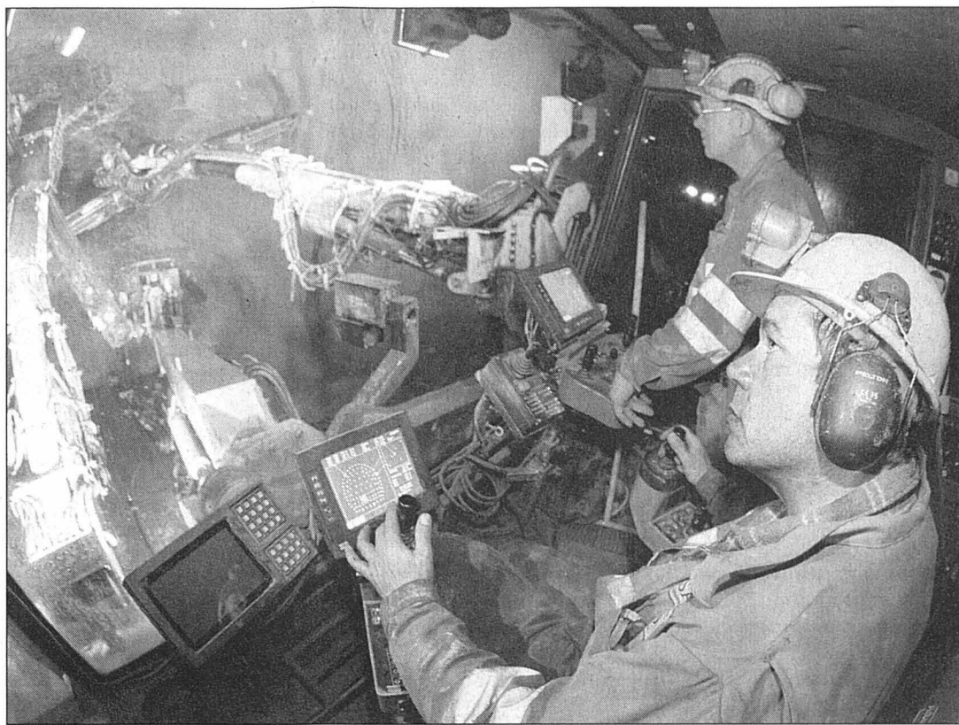
Le projet NLFA est adapté en permanence aux nouveaux développements techniques.
