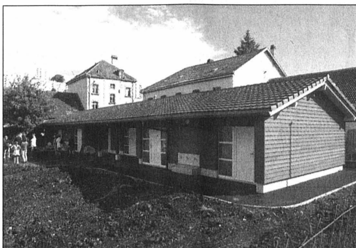
Les nouveaux locaux sont composés de modules juxtaposés.
