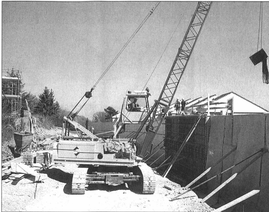
A Corcelles, les premiers murs de protection ont été érigés dans le haut du village. Ces travaux sont liés au giratoire de la Chapelle.
