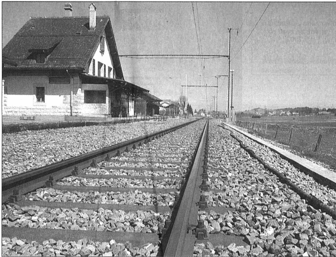
Au Crêt-du-Loche, la H20 passera au sud de la voie ferrée (à droite sur la photo). Un premier chantier s'ouvrira à la hauteur du passage à niveau. PHOTOS LEUENBERGER
