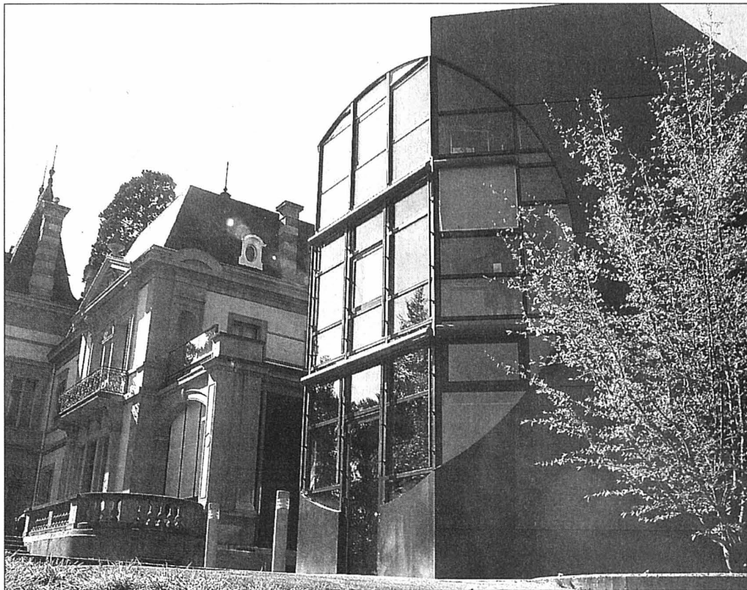
Le concours vise à conserver la beauté du site, mais en créant plus d'espaces de rencontres entre ses utilisateurs.
