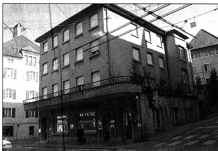
L'immeuble reprendra vie.
