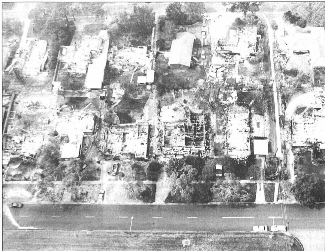
Ruines fumantes d'un quartier ravagé par le feu à Canberra.
