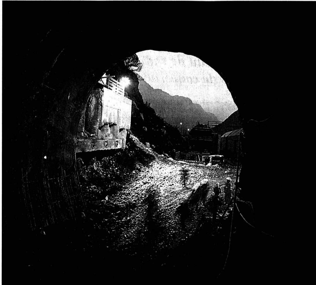
Bodio, portail sud du tunnel.
