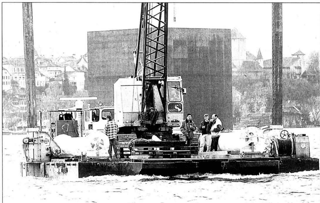
Chargés sur une barge, les trois cylindres contenant le panorama de la bataille de Morat ont été transportés jusqu'à Sugiez, puis acheminés par camion en direction de Grolley, où la fresque attend désormais sa nouvelle affectation.
