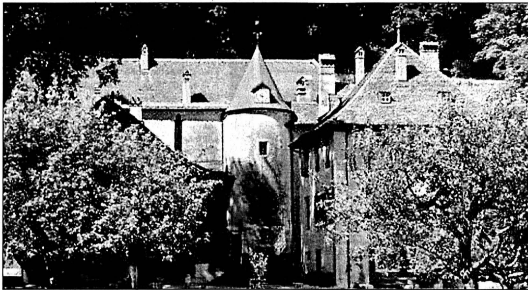
Des allures de résidence de campagne.
