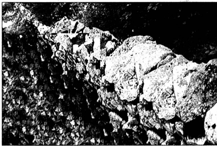
Des lectures au long du mur de pierres sèches... PHOTO SP
