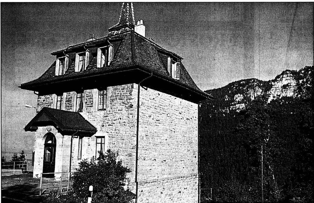
Le crédit de 186.000 francs pourra être engagé pour rénover la cage d'escalier et l'appartement du 2e étage de l'ancien collège de Fretereules. PHOTO MARCHON
