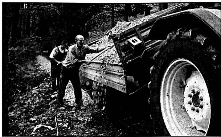
La remise en état des banquettes, hier, avec les agriculteurs qui ont mis la main à la pâte bénévolement. Au premier plan, Claude Schoenberg, chef des Travaux publics municipaux et responsable du projet. PHOTO EGGLE
