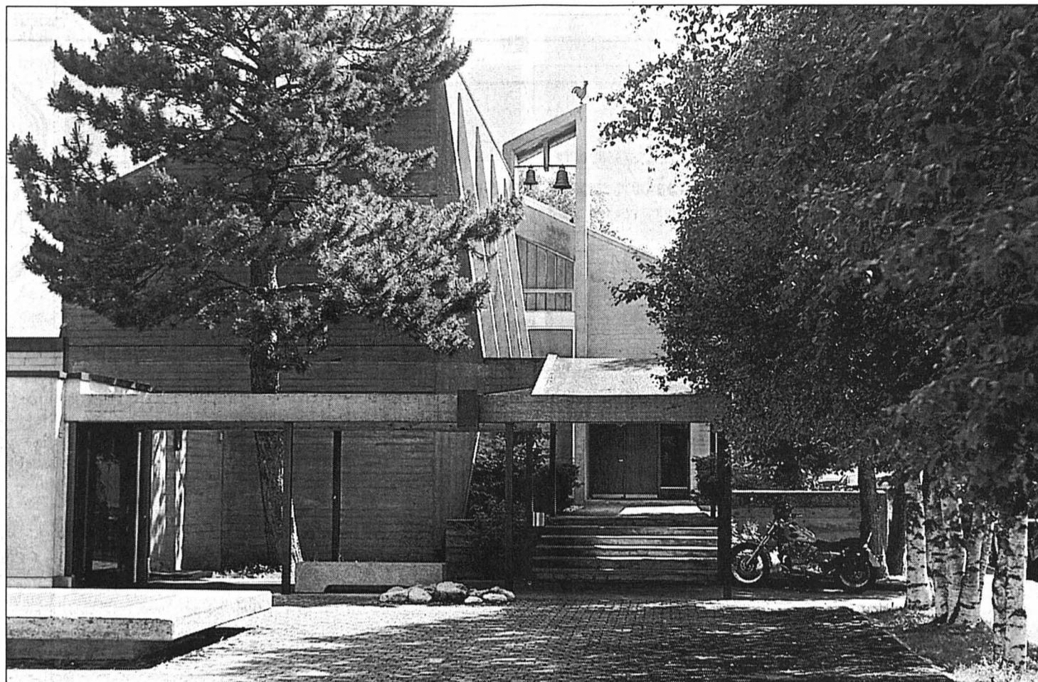
De loin, il n'y paraît pas, mais le béton des années 60 n'a pas très bien supporté les outrages du temps. PHOTO GALLEY
