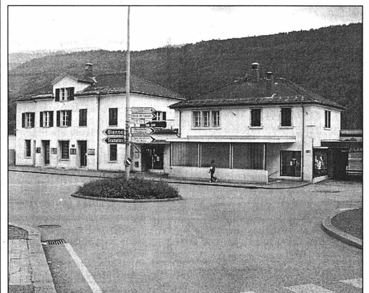
La gare de Saint-Imier deviendra la porte d'entrée et d'accueil de la localité. PHOTO ODIET
