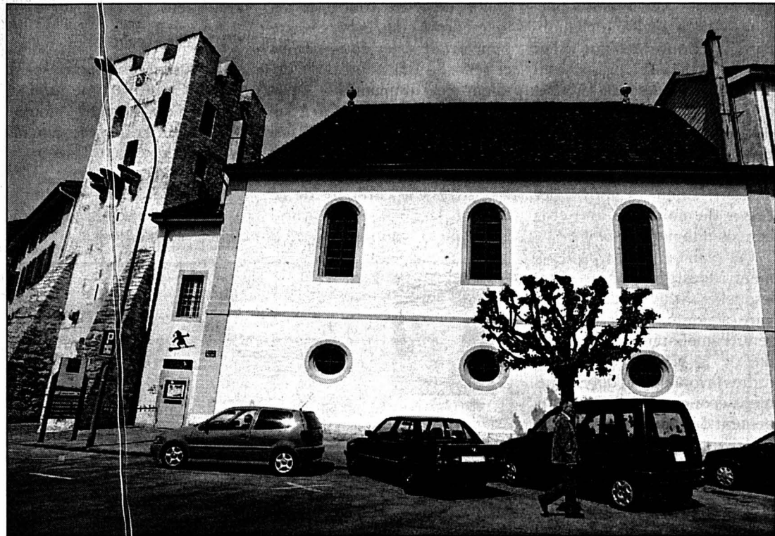
Classé monument historique, l'ancien temple de La Neuveville ne subira aucune retouche. Une infrastructure légère à l'intérieur suffira à donner vie au café-théâtre de la Tour de Rive. PHOTO MARCHON
