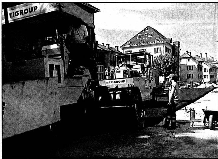
Une longue journée pour les ouvriers afin de terminer le chantier à temps, surtout avant la pluie. PHOTO PERRIN
