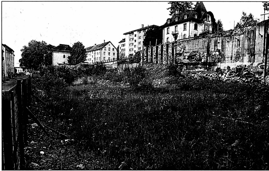
Un immeuble de bureaux, petite industrie et artisanat devrait prendre place dans le trou béant de La Comète.
