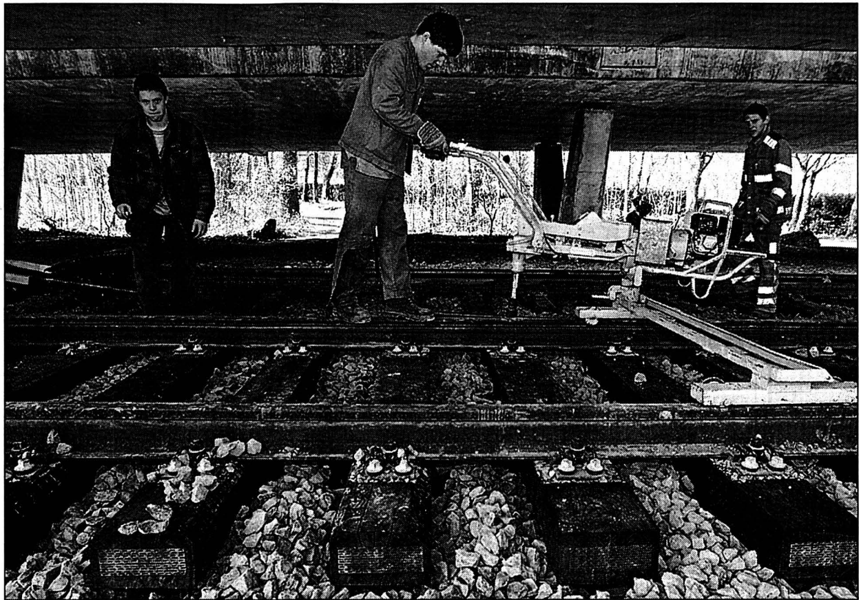
Les jeunes apprentis construisent, en site scolaire, une double voie type CFF sous l'autoroute A5.
