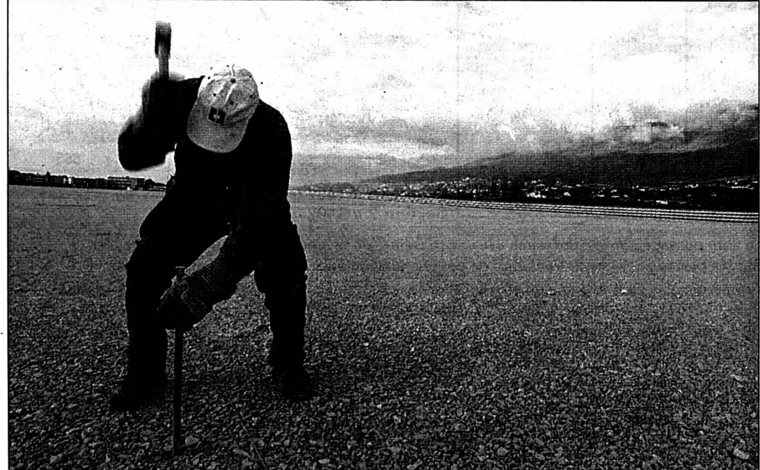
Derniers coups de marteau avant l'ouverture d'Expo.02... Ici, sur le futur parking de Marin-Epagnier. PHOTO DAVID MARCHON
