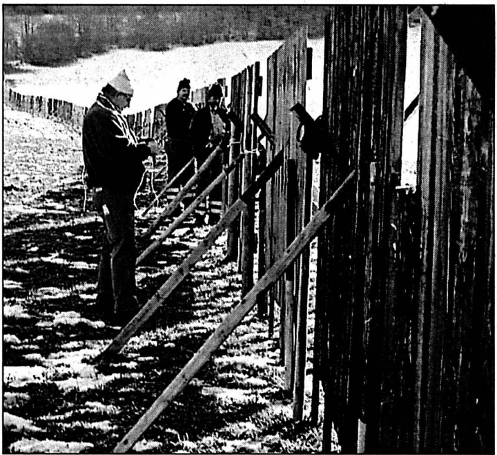
Les employés de la voirie ont posé plus de 340 barrières de protection contre la neige. PHOTO PERRIN
