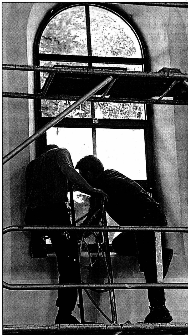
La pose des douze nouveaux vitraux de Dombresson s'est déroulée sans problème, hier matin.
