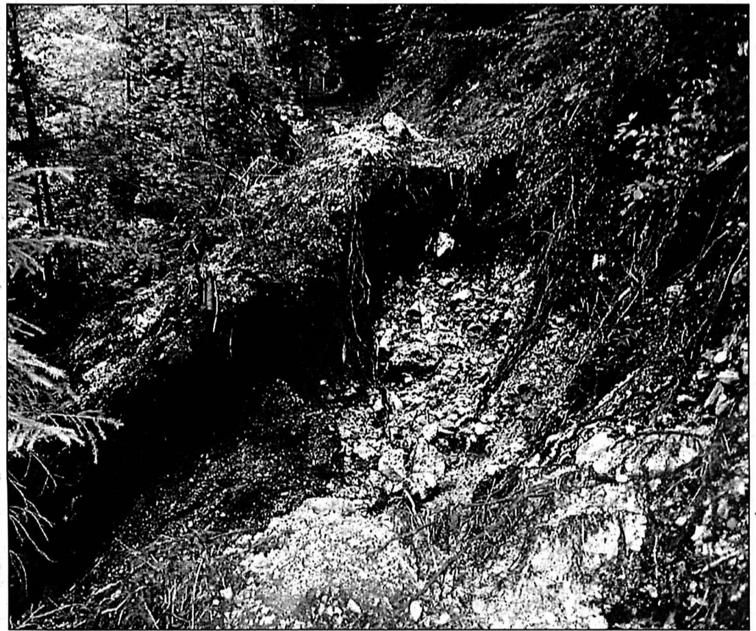
Sur plusieurs mètres, le sentier Kohly ne répond plus. Il a été emporté par les eaux.
