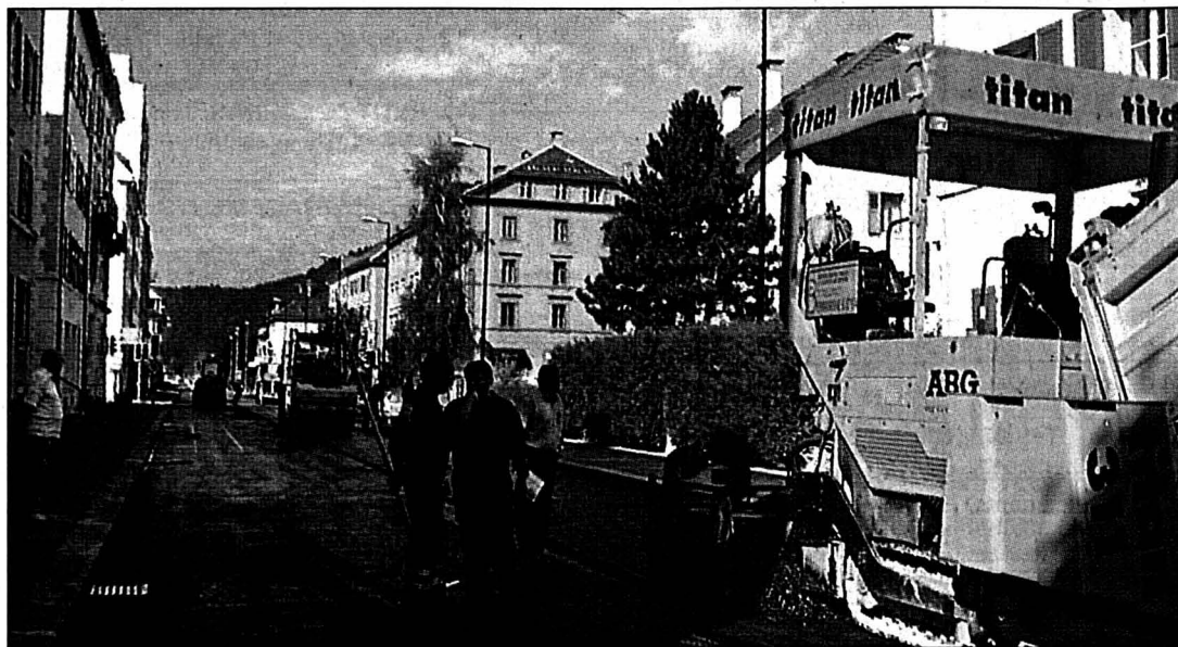
En une journée, le secteur de 335 mètres qui a fait l'objet d'une réfection en surface a été revêtu d'une couche bitumeuse de trois centimètres. PHOTO PERRIN
