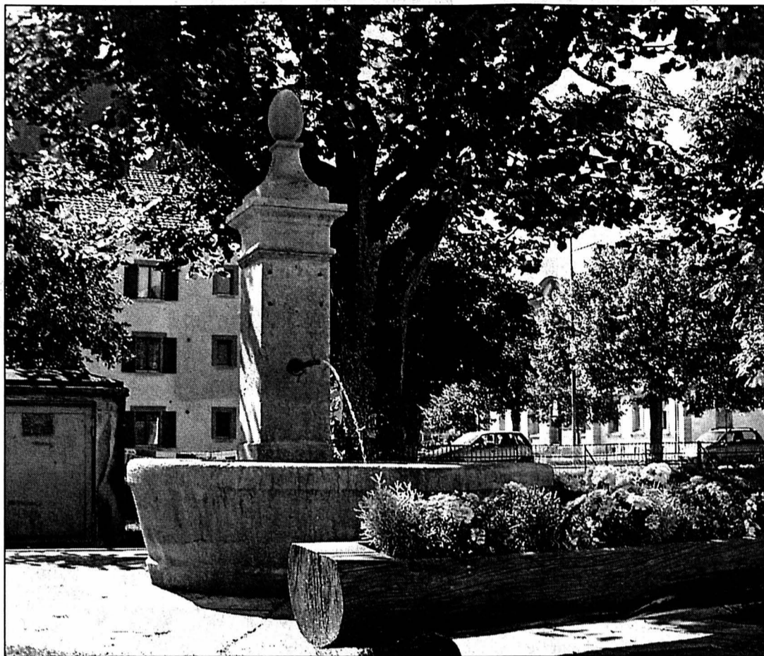
Un bassin ovale, une pile surmontée d'un gland: une des fontaines (rue de la Promenade à Fleurier) caractéristiques du Vallon.
