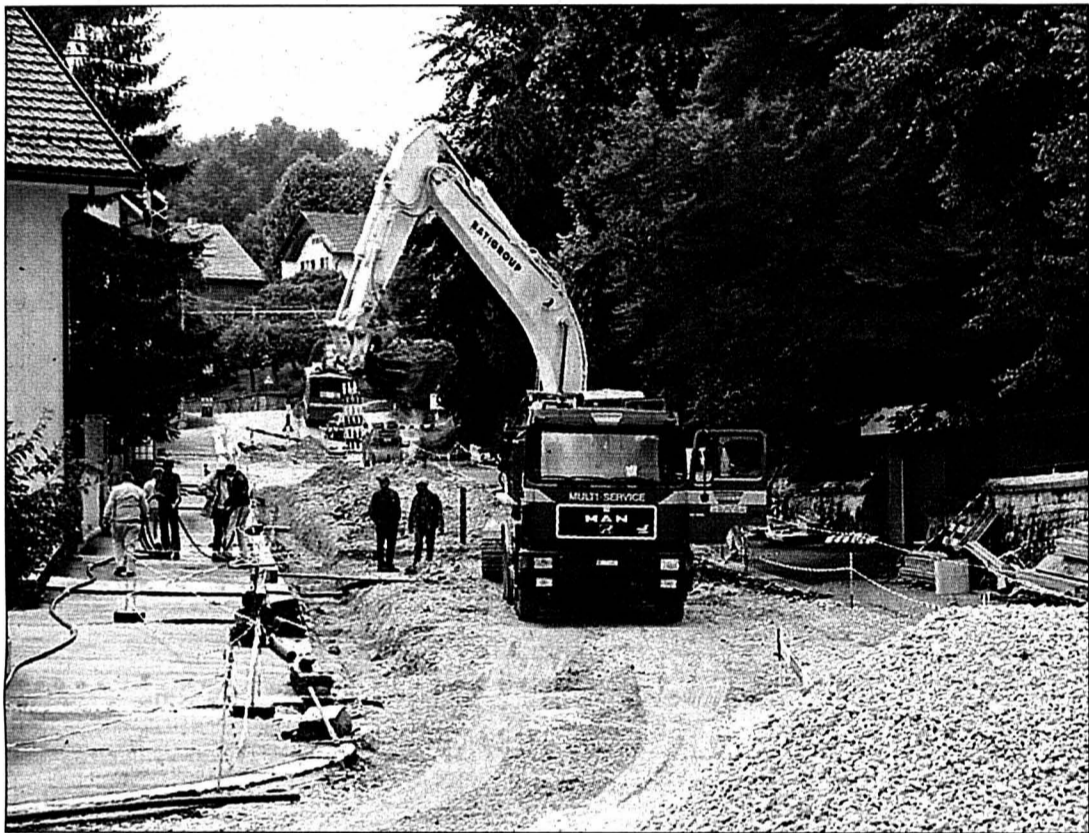
Rue du Succès, le chantier se terminera vraisemblablement avant la date prévue.
