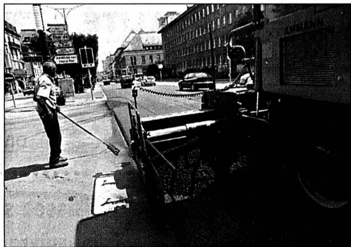
Le tapis de bitume est posé par tronçon sur le Pod.
