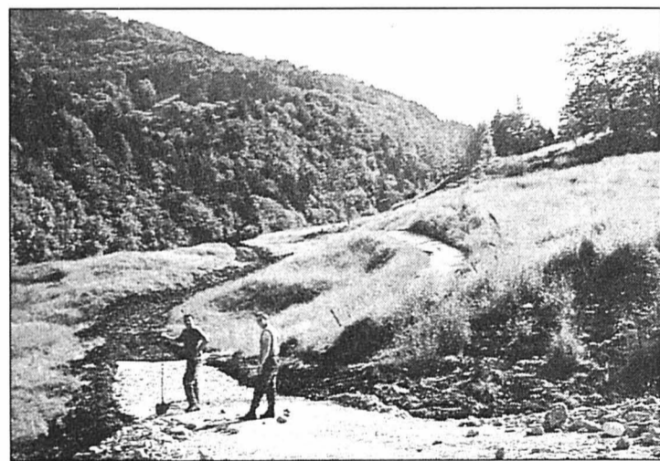
Une troupe du génie est venue prêter main forte à l'aménagement de la voie provisoire. PHOTO GOGNIAT
