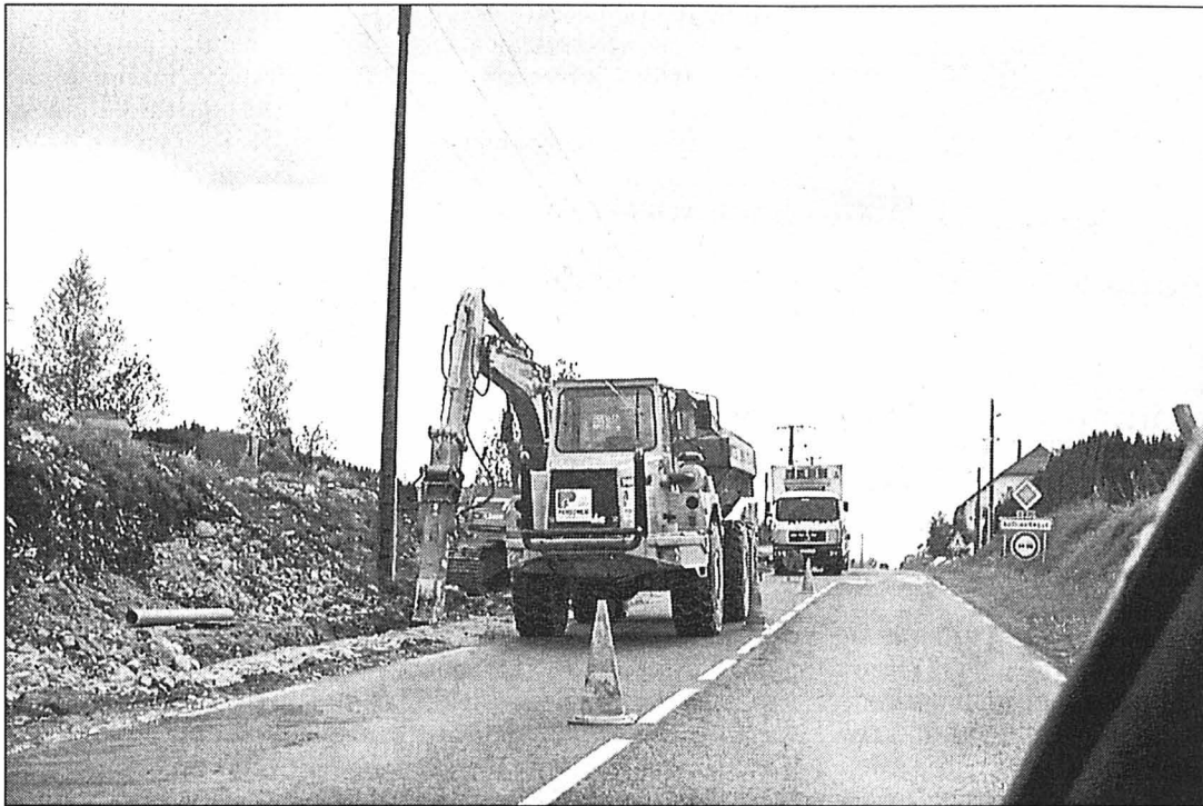
Les chantiers routiers vont se multiplier dans le Haut-Doubs horloger.
