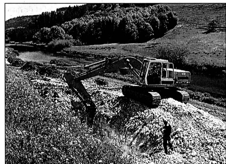
Le chantier d'assainissement retiendra les effluents de cinq communes qui se mêlaient jusqu'ici aux eaux du Doubs. PHOTO PRÉTRE
