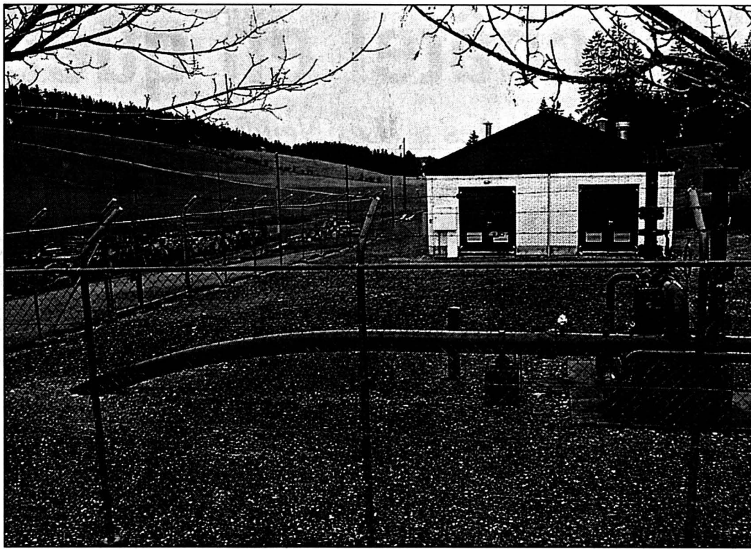
Un poste de Gansa au Foulet, au sud de La Chaux-de-Fonds.
