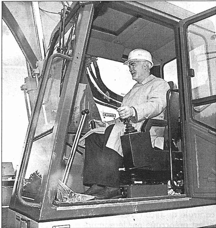
Un chantier inauguré hier sur le site de la future Haute Ecole pédagogique (HEP) à La Chaux-de-Fonds. PHOTO GALLEY
